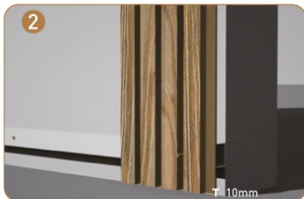
Fissare il primo pannello di rivestimento della parete sui magatelli usando viti colorate, se rimarrà a vista, altrimenti autofilettanti se sarà coperto da un profilo a L o da un profilo ad angolo.
