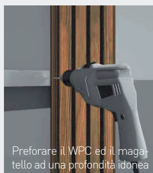
Fissare il WPC al magatello con viti in acciaio SSD
